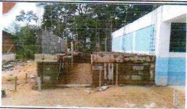
Foto 1: Sustitución total de la pared de baño
