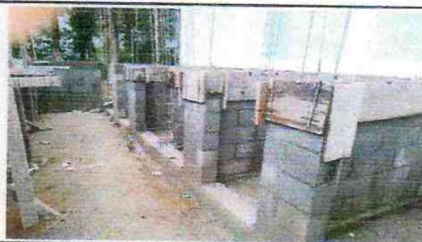
Foto 6: Sustitución total de piso para baño
