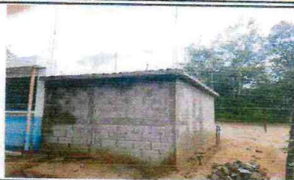
Foto 2: Sustitución total del techo de los baños
